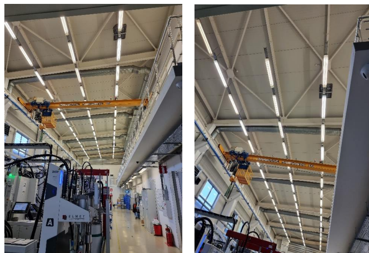
Старо конвенционално осветление в производствените помещения
