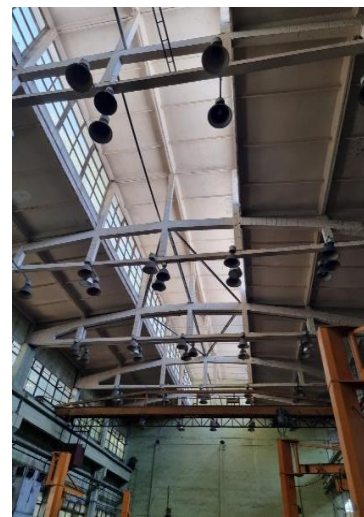
Старо конвенционално осветление в производствените помещения
