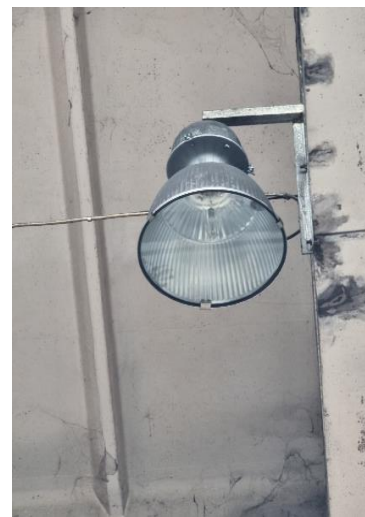
Старо конвенционално осветление в производствените помещения
