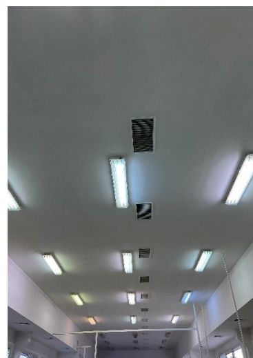
Старо конвенционално осветление в производствените помещения
