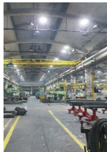
Старо конвенционално осветление в производствените помещения
