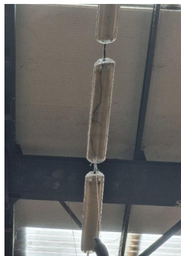
Старо конвенционално осветление в производствените помещения
